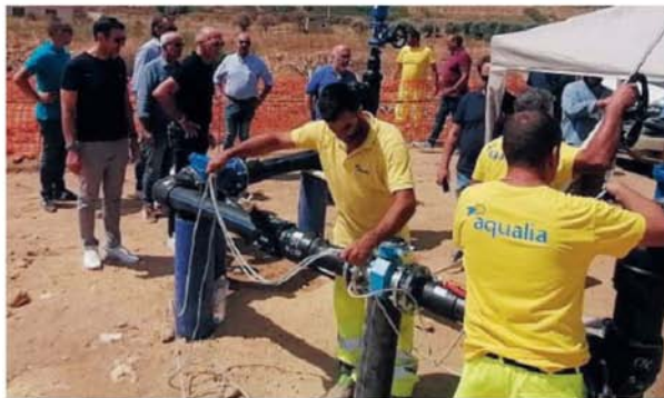
Caltanissetta. Al lavoro per rendere operativi i nuovi pozzi
