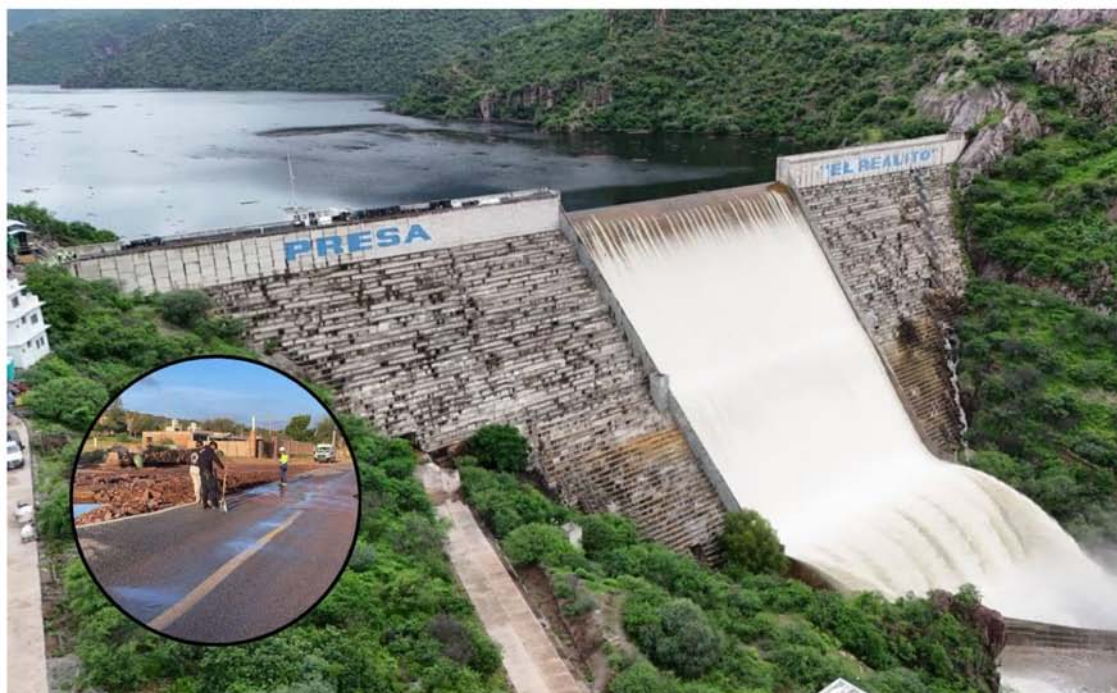
Aún sin entrar en operaciones, Realito ya presentó dos fallas en la última semana. Foto: Especial
